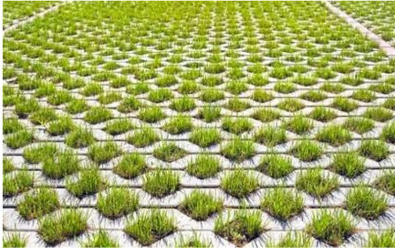
Exemple de parking en revêtement alvéolaire béton.
